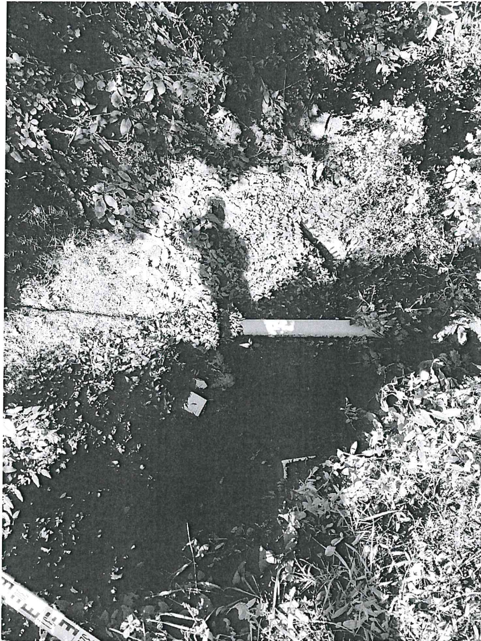
7. kép: a csőáteresztől 70 fm-re parfal kimosódás, szélessége 320 cm, mélysége 220 cm
