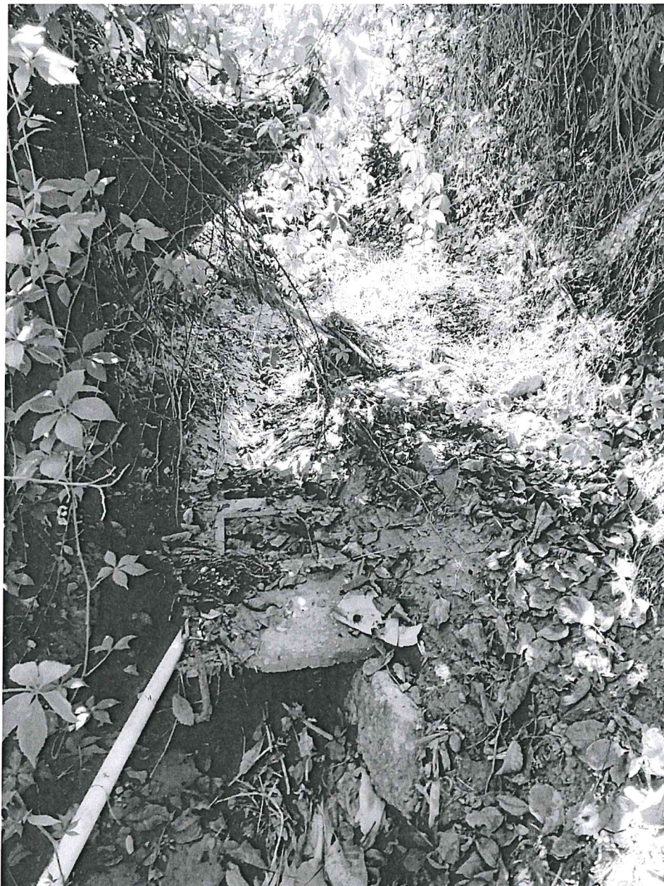
6. kép: fenéklépcső feletti betonlap burkolat Vörösmarty u. felöli árok bevezetésnél
