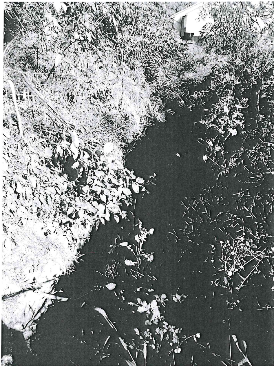
3. kép: 20,0 fm – 40,0 fm közötti szakaszon földpartú szabvány árok, az árokfenéken 50-60 cm mély kimosódással
